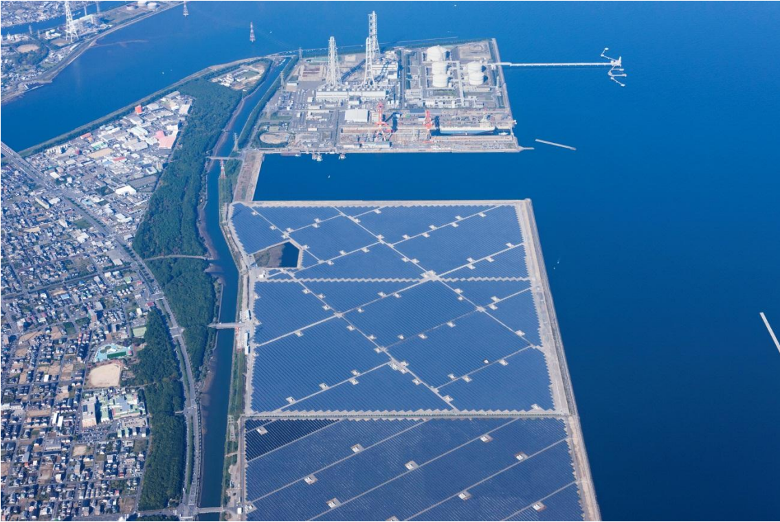
【Oita solar power plant, aerial photos】
