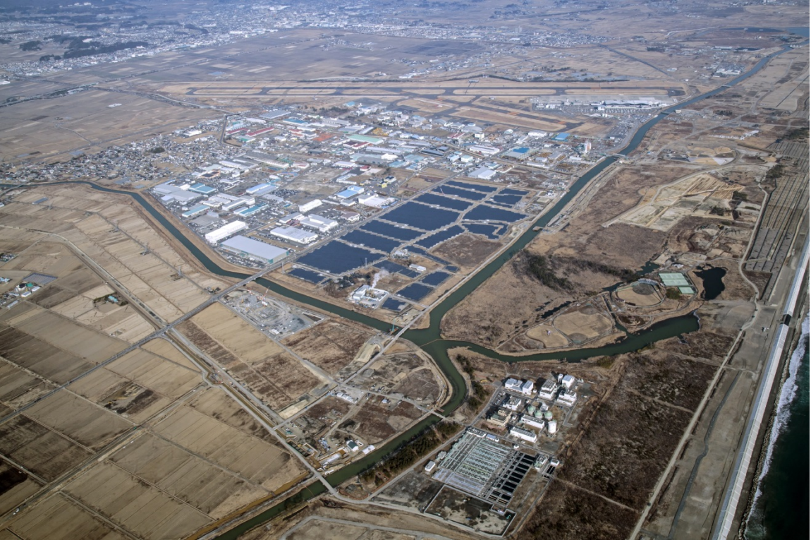
【Aerial view of Iwanuma Rinku Mega Solar Power Plant】
